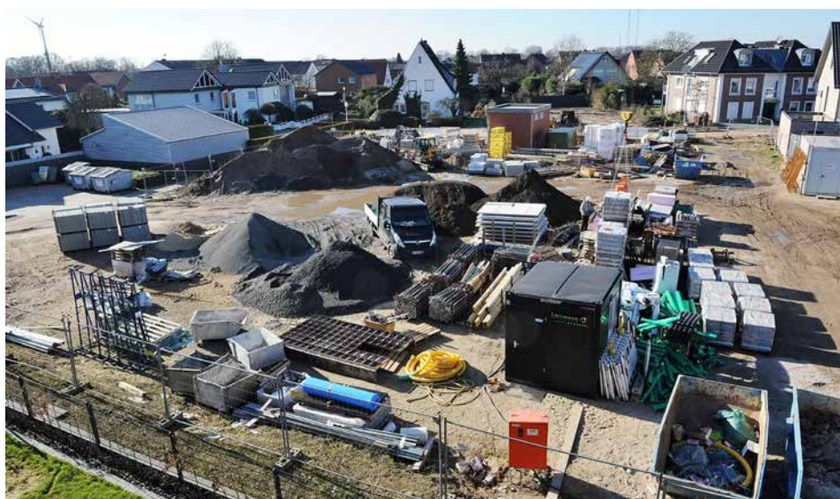
Baubeginn für die Besondere Wohnform in Recke soll am 1. August auf diesem Grundstück sein. Dort werden 2028 dann 24 Menschen mit hohen Hilfebedarfen einziehen.
